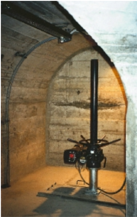
Bild 4. Beispiel einer elektromechanisch angetriebenen Schütze.
